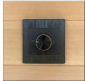
Zwei Strahler an der Rückwand lassen sich durch die jeweiligen Regler darüber komplett ausschalten oder je nach Belieben die Temperatur hoch- bzw. runterregeln.
