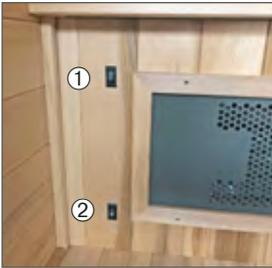
Neben dem Fußstrahler der Front sind zwei Schalter angebracht. Der obere Kippschalter ① ist zum An- und Abschalten des Fußstrahlers, der untere Kippschalter ② ist zum An- und Abschalten der Fußbodenheizung.
